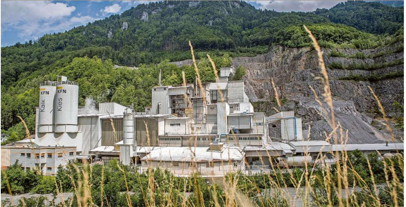
25 Tonnen Nutzlast: Die Kalkfabrik wird Gestein und Kalk aus dem neuen Abbaugbiet bei Gründen (oben links) mit einer Materialeiseilbahn zum Grund des alten Steinbruchs (unten rechts) transportieren.
